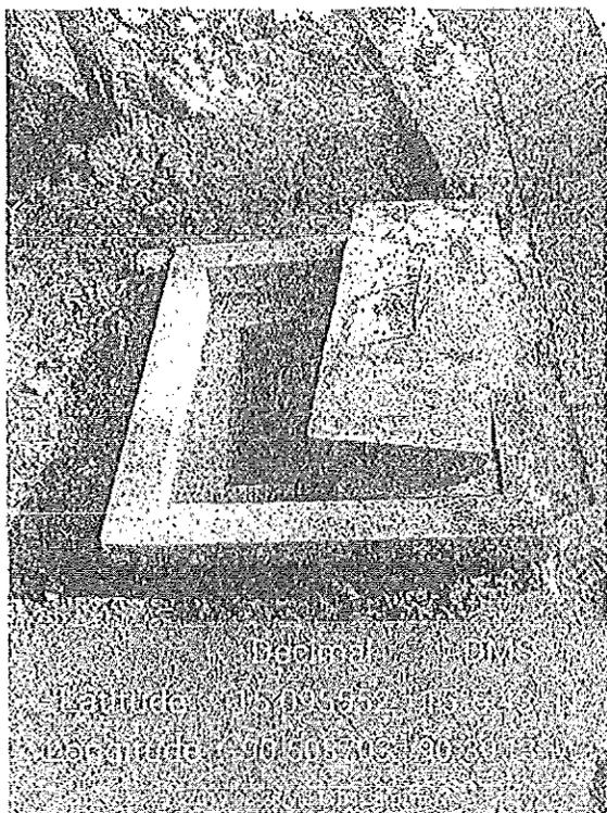
Foto No.8 Caja para válvula de compuerta
